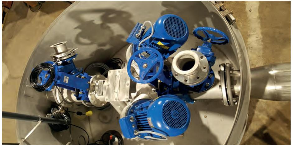
Le DIP Booster a déjà été installé à Washington pour booster une canalisation d'écoulement de 250 mm de diamètre sur 800 m de long.
