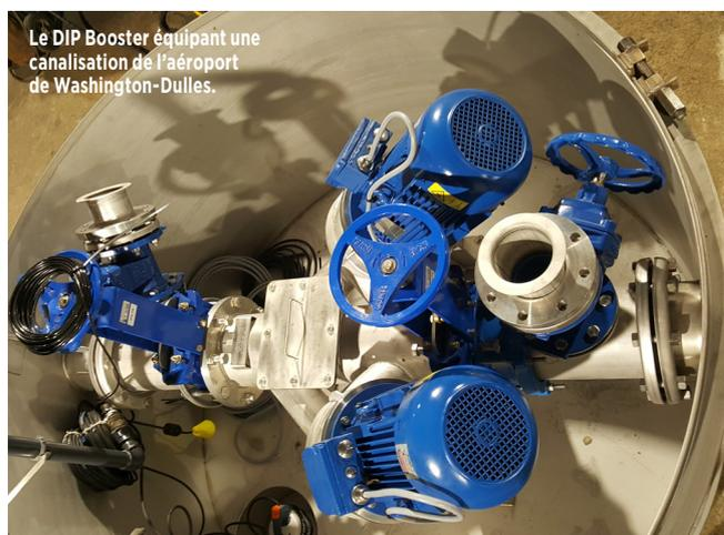
quand le niveau monte, et que le taux de remplissage de la conduite sort de la norme, alors le système va automatiquement démarrer, boostant le flux à l'aval pour en augmenter la vitesse, et donc le débit.
