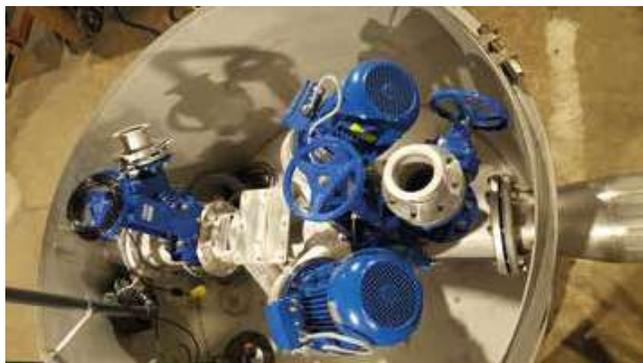
Installation du DIP-Booster à l'aéroport international de Washington-Dulles, pour équiper une de ses canalisations manquant de pente.
