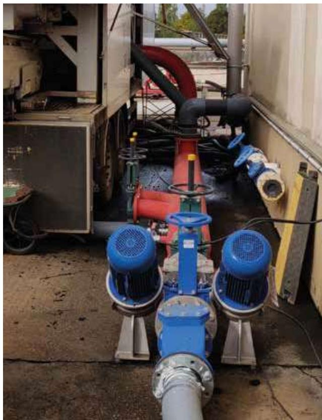
Installation à la station d'épuration d'Achères, qui a choisi de s'équiper d'un DIP-Booster pour la reprise des filtrats de centrifugeuse à boues.
